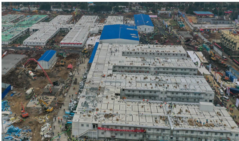
Figura 1: Construcción de hospitales en Wuhan (China) Enero 2020
