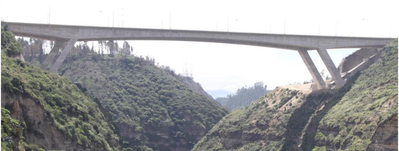
Figura 4. Vista general de los puentes terminados.
