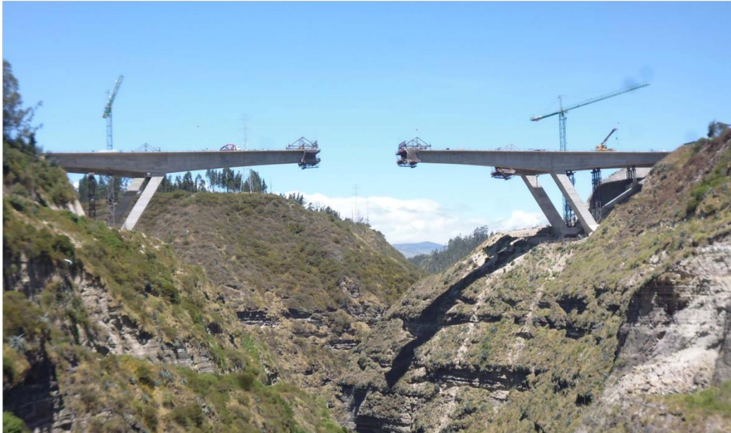
Figura 14. Ejecución de dovelas con carros.
