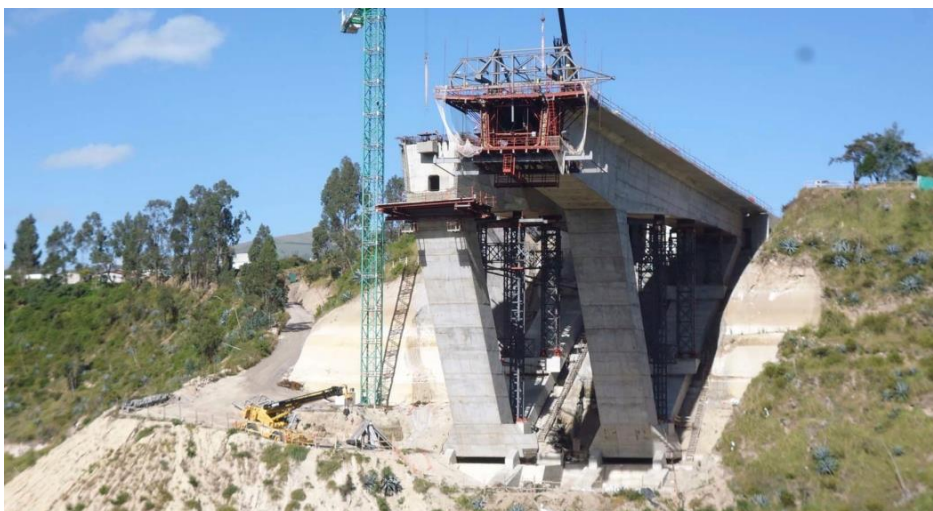
Figura 13. Instalación del carro de dovelas.
