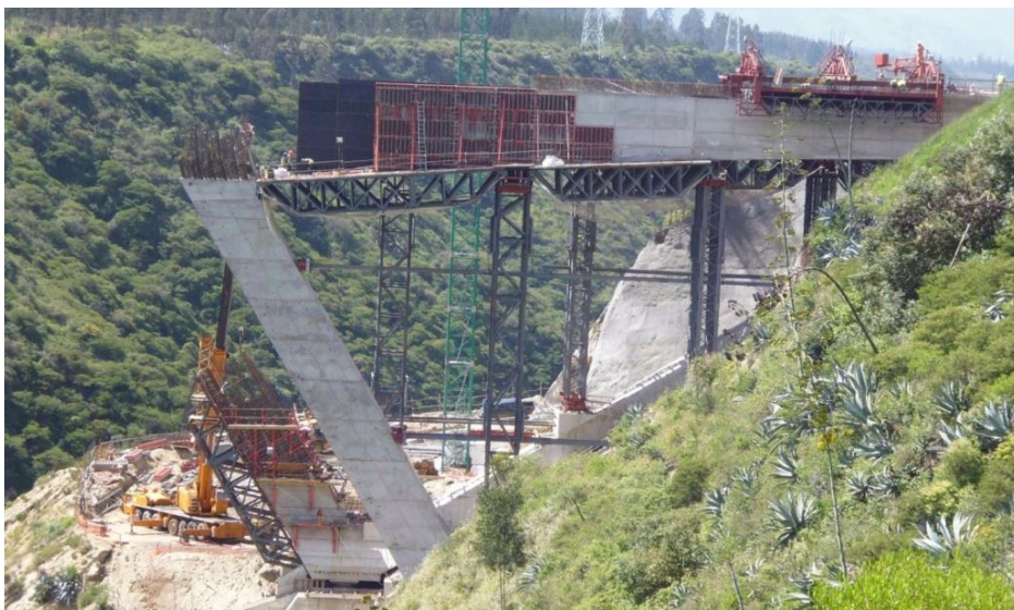
Figura 12. Hormigonado de los vanos laterales.
