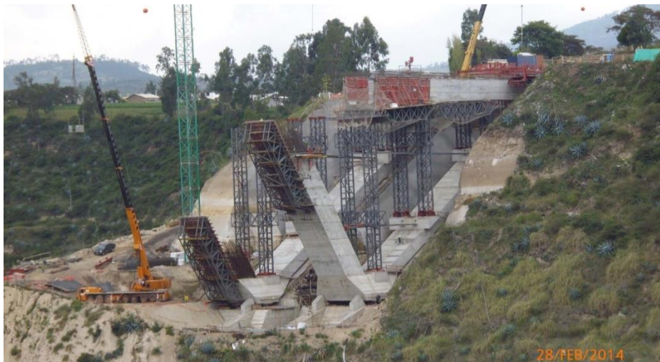
Figura 11. Hormigonado de la pila frontal.
