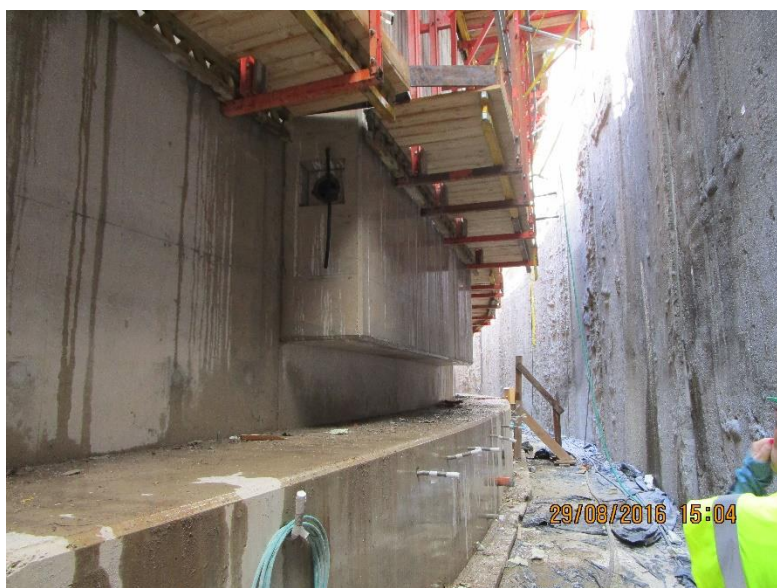
Figura 9. Detalle encuentro contrafuerte – losa
