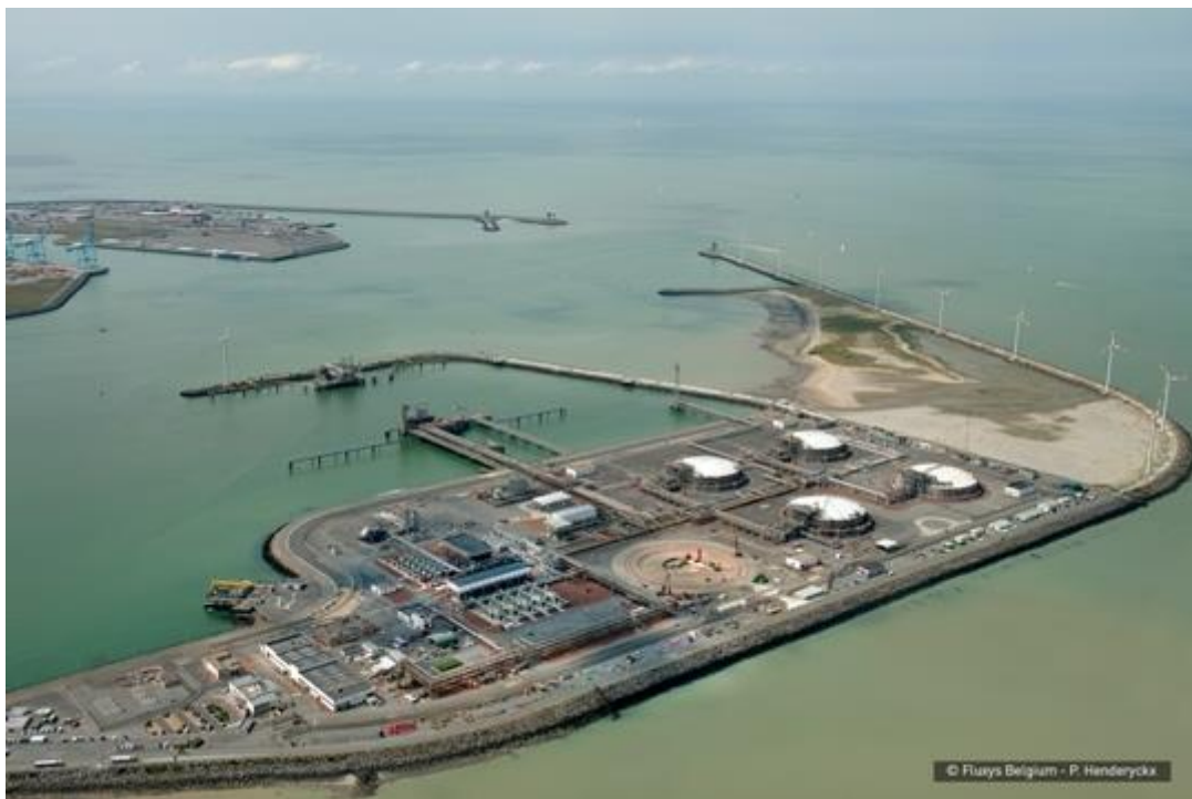
Figura 1. Vista aérea de planta de GNL Zeebrugge.
