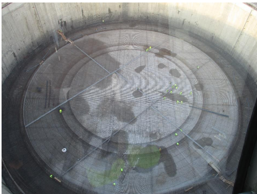
Figura 8. Visa aérea armadura de losa
