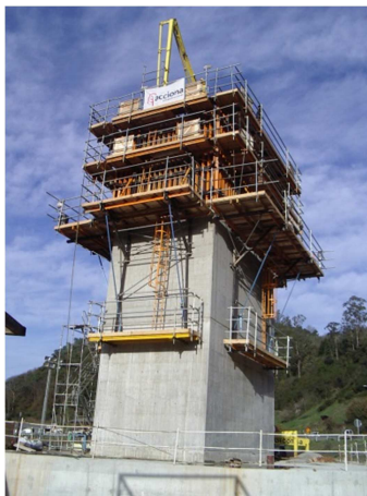
Figura 4. Encofrado trepante para ejecución de pilas.
