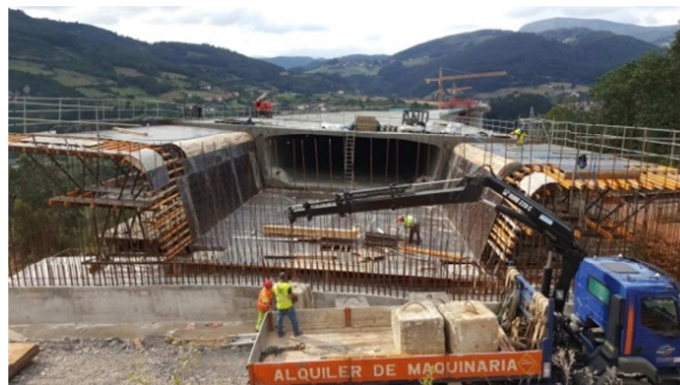
Figura 18. Ejecución de dovelas cimbradas en Estribo 1.
