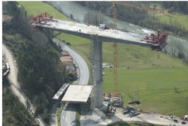
Figura 15. Ejecución del tablero en Pila 2
