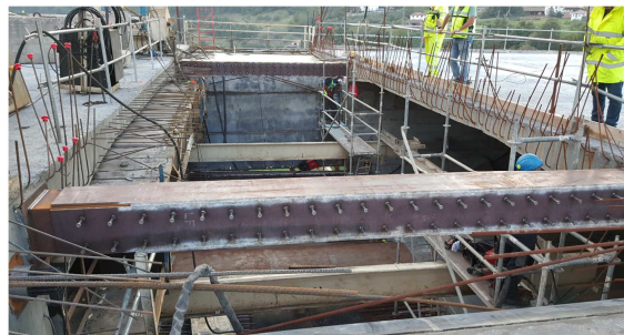
Figura 17. Bloqueos en dovela de cierre
