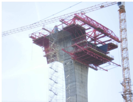
Figura 13. Montaje del carro de voladizos sucesivos
