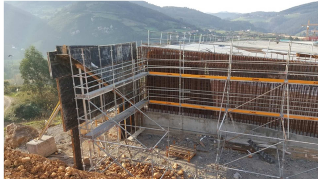
Figura 6. Ejecución del alzado del Estribo 1.
