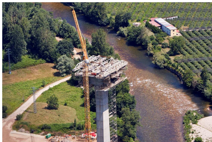
Figura 14. Cross-member en Dovela Cero sobre Pila 4
