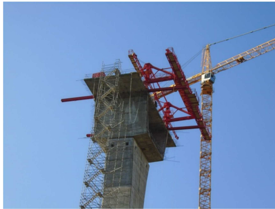
Figura 12. Montaje del carro de voladizos sucesivos
