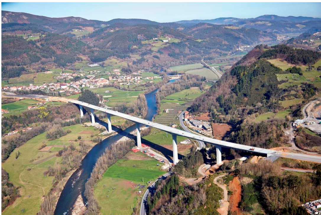
Figura 19. Viaducto sobre el río Narcea.
