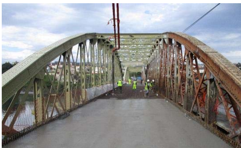
Figura 8. Hormigonado de losa en tramo fijo.
