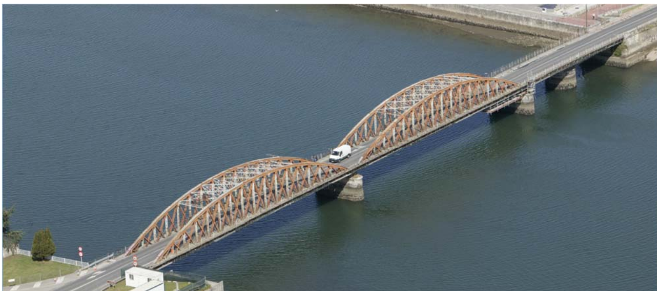
Figura 1. Vista general del Puente de Treto sobre la ría del Asón.
