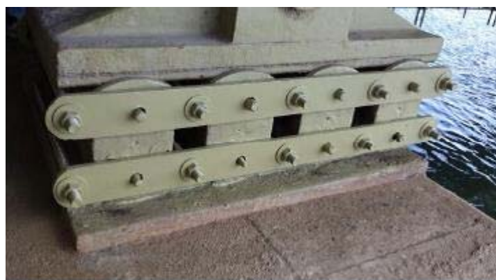
Figura 10. Aparato de apoyo rehabilitado previo al engrasado.
