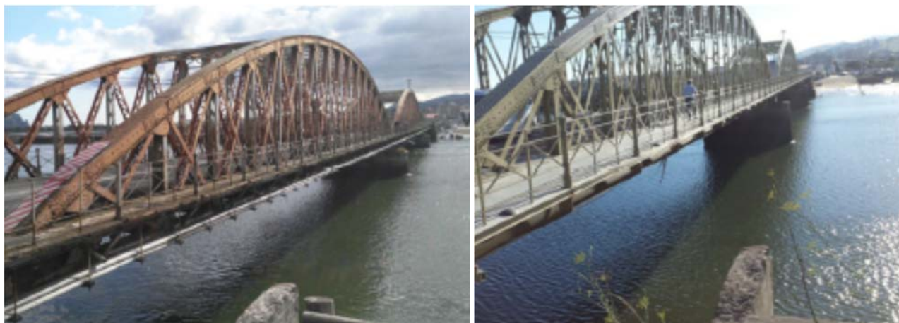
Figura 12. Vista general del puente. Antes y después de la intervención.
