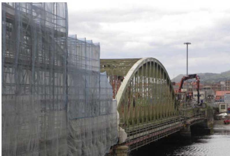
Figura 9. Encapsulado del puente por tramos.
