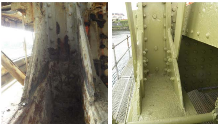
Figura7. Rehabilitación de viga principal. Antes y después de la intervención.
