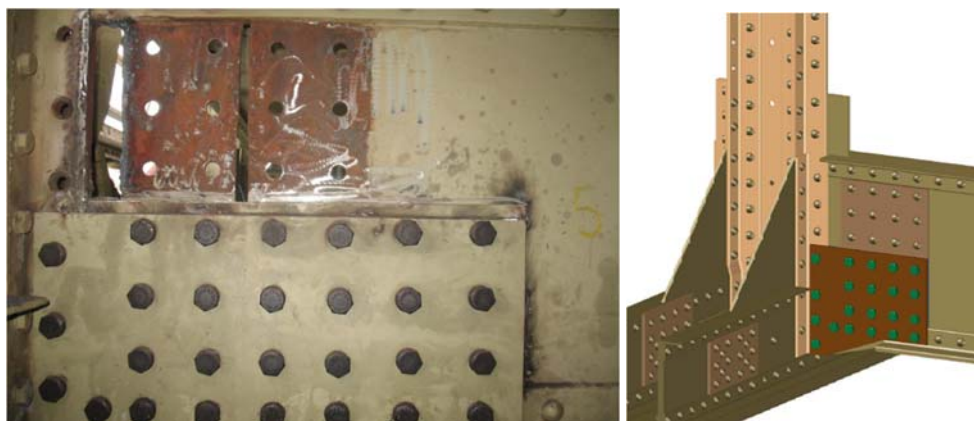
Figura 5. Rehabilitación de nudo inferior.
