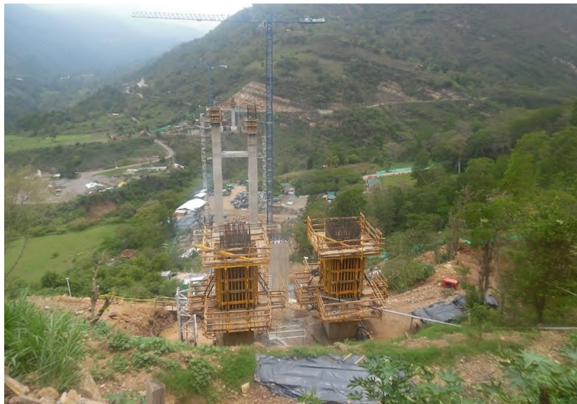
Figura 12. Arranque ejecución Pila 1 con Pilono
